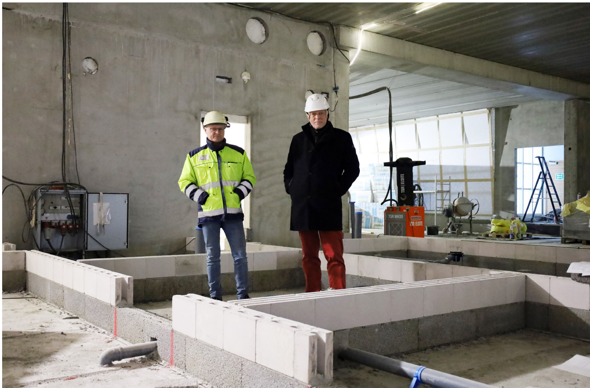
Simhallsrenoveringen är snart halvvägs. Jan Östman och Anders Dahlbäck står i det som ska bli ett omklädningsrum. Bakom dem kommer gymmet. FOTO: CHRISTINE SMEDBERG
